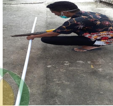
Foto 2. Pipa Ukuran \frac{1}{2} dipotong dengan ukuran 1 meter
