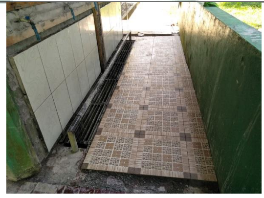
Pemasangan Tegel air wudhu
