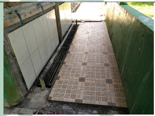
Pemasangan Tegel air wudhu
