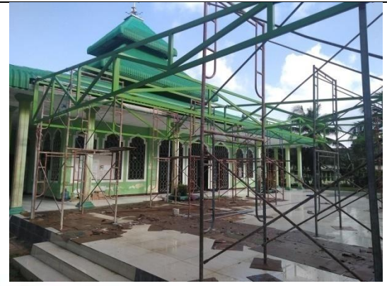
Pemasangan knopi masjid
