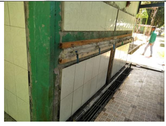
Pemasangan Tegel air wudhu
