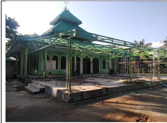
Pemasangan knopi masjid
