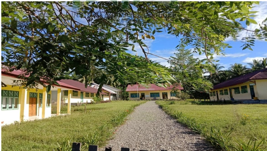
Gambar 2. Kondisi Bangunan Sekolah
