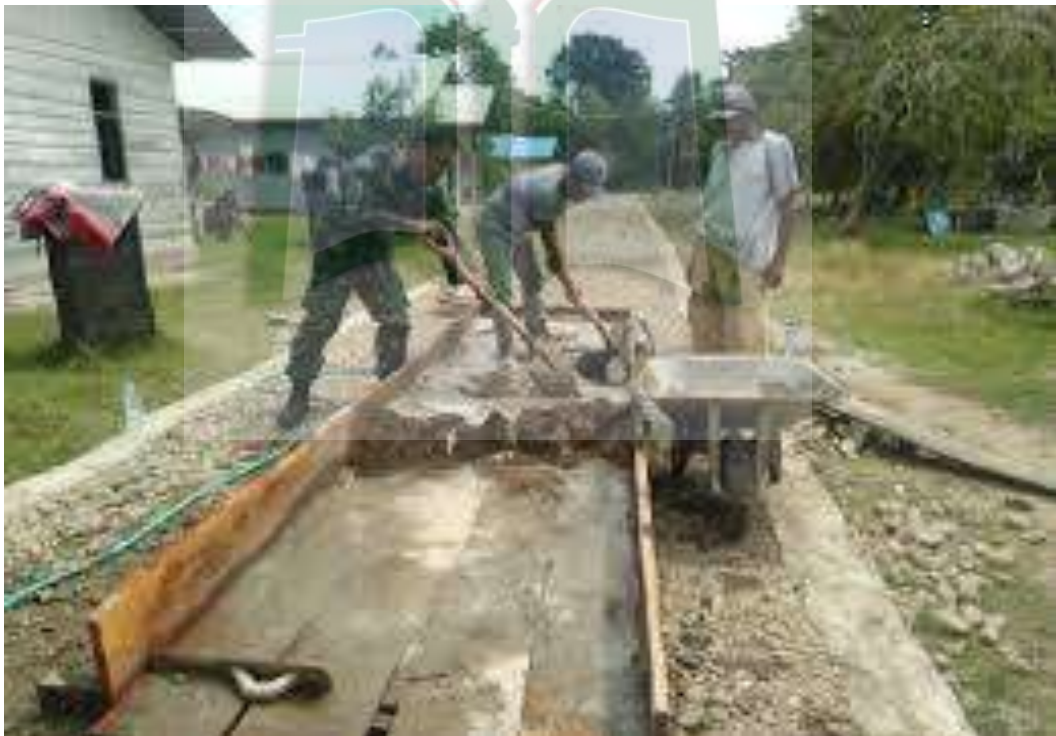
Foto 6. Pembangunan Jalan Setapak Desa Tetoat
