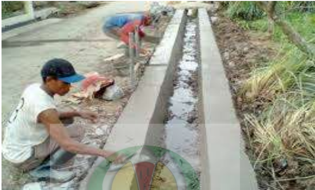
Foto 5. Rehabilitasi Air/Drainase/Gorong-gorong desa Tetoat
