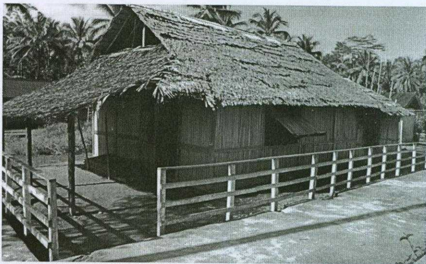
Gambar 9 Salah Satu Rumah Guru yang Dibangun oleh Warga dari Gaba-Gaba (Batang Pohon Sagu)
