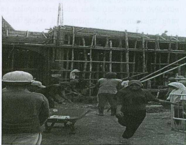
Gambar 5 Bentuk Gotong Royong dalam Pembangunan Masjid di Desa Tehoru
