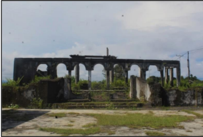
Gambar 9. Bangunan Mesjid Iha di Saparua
