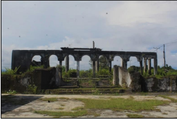
Gambar 9. Bangunan Mesjid Iha di Saparua
