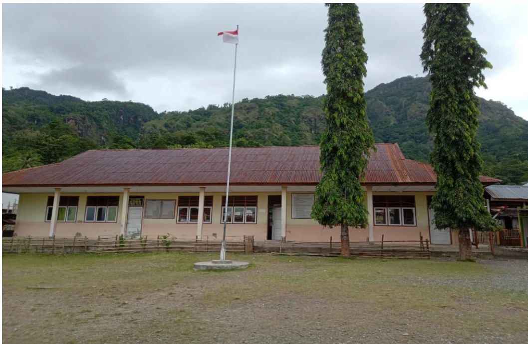
Foto 2. Gedung Sekolah SDN Tonu Jaya
