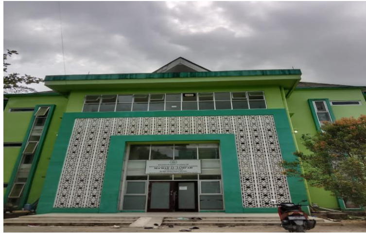
Gambar 7. Gedung Arama Putri
