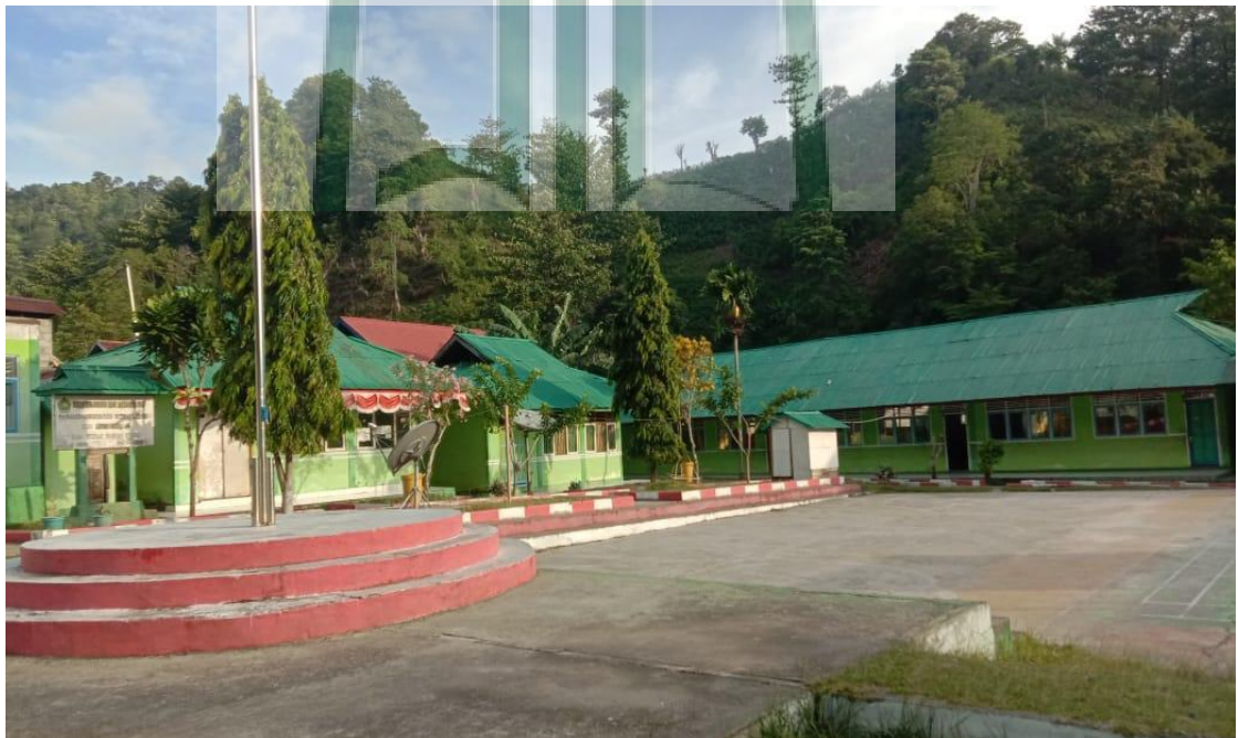
Gambar 2. Gedung MIN 1 Seram Bagian Barat
