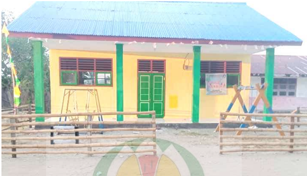
Foto 7. Bangunan PAUD Desa Suru
