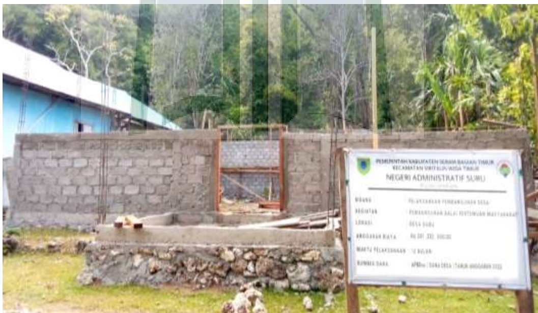
Foto 6. Tahapan Pembangunan Balai Desa Suru
