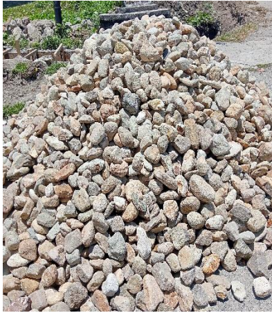
Bahan – Bahan Pembangunan drainase
