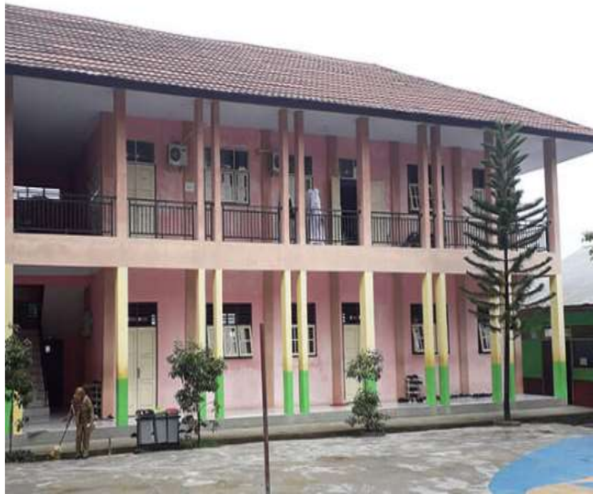
Gambar. 1.1. Gedung Kelas SMP Negeri 14 Ambon.
