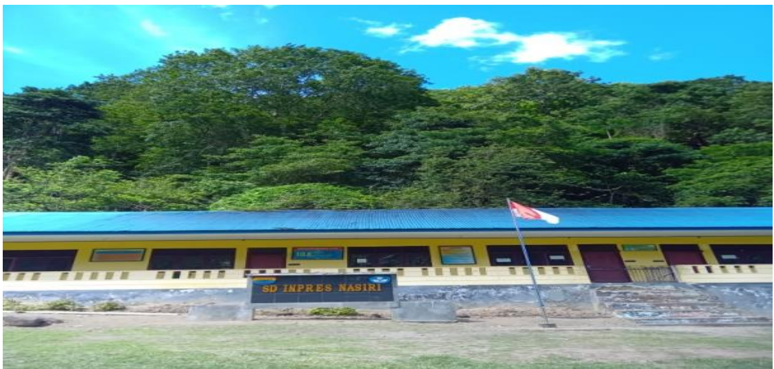
Foto 2: Bangunan SD Inpres Nasiri
