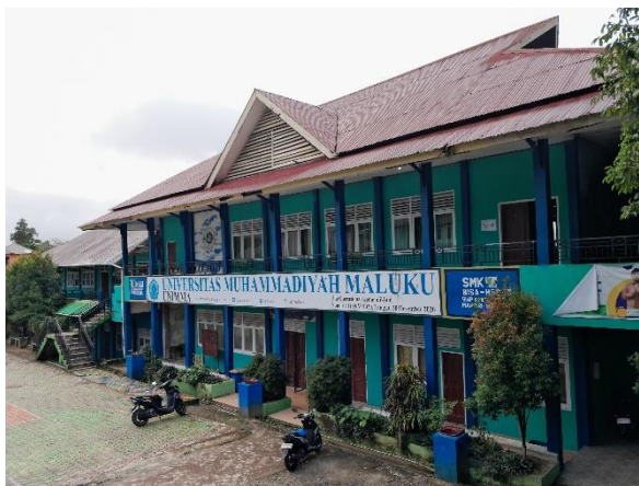
Gambar 9: Gedung Aula SMK Muhammadiyah Ambon
