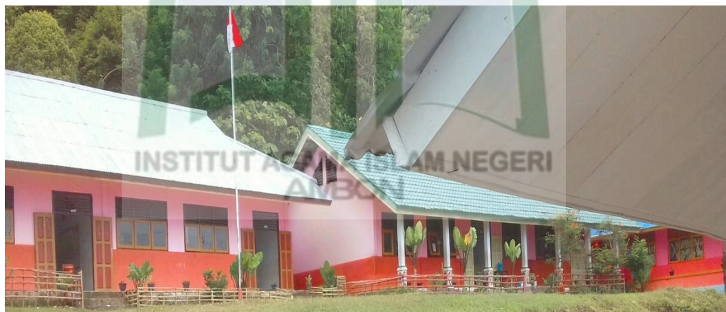
Foto 2. Gedung SMP Negeri 5 Leihitu Barat Satu Atap
