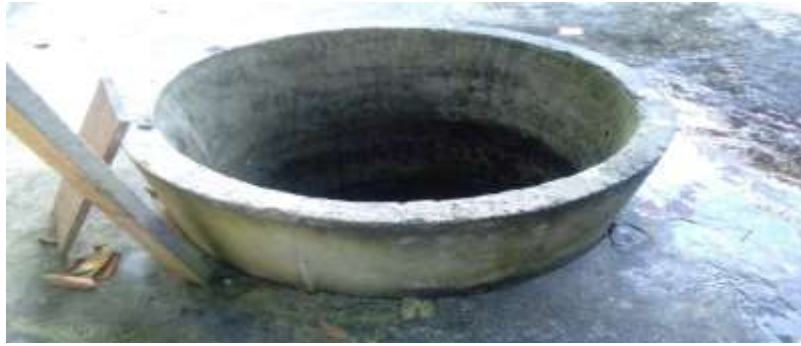
Sumur yang berjarak 81 dari tempat pembuangan sampah (S3)
