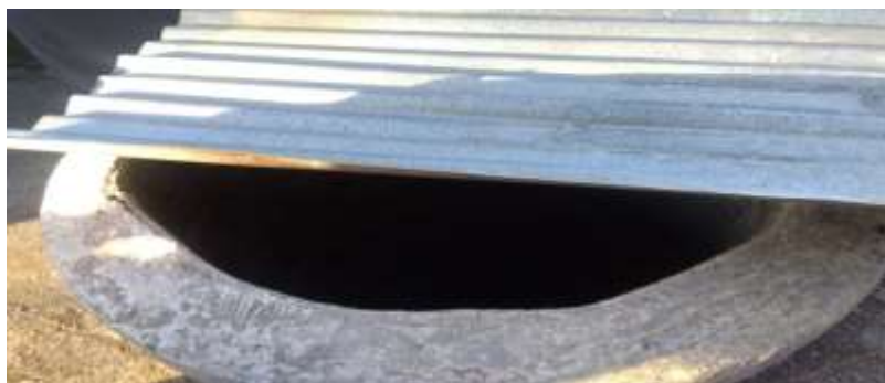
Sumur yang berjarak 150 dari tempat pembuangan sampah (S6)
