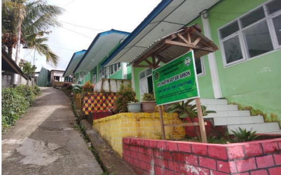
Gambar 1. Fasilitas Lingkungan Sekolah
