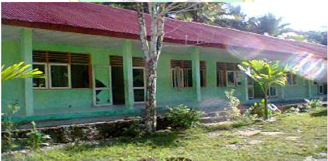
Gambar. Gedung Sekolah MTs Limboro
